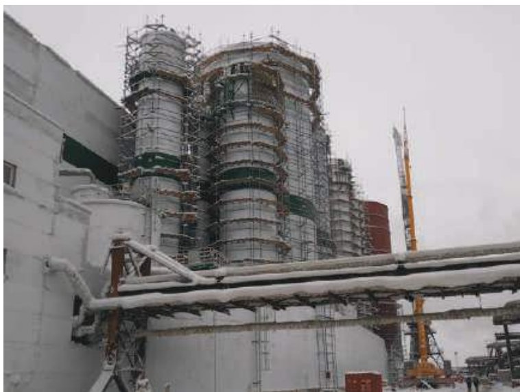
Рис. 10. Монтажные леса вокруг резервуаров
