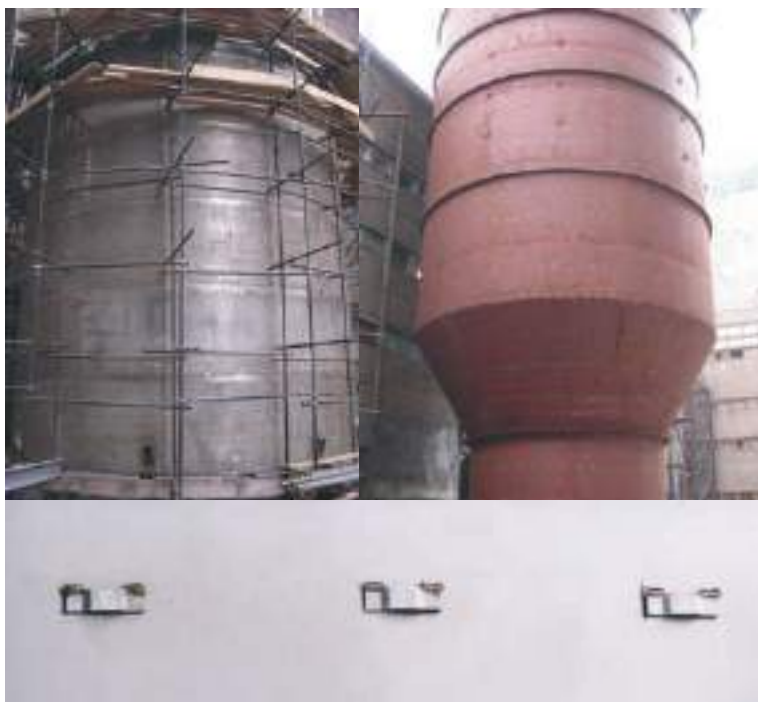
Рис. 3. Вид резервуаров и нестандартных скоб для крепления теплоизоляции
