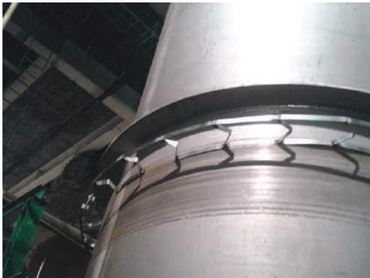
Рис. 9. Крепление опорных поясов на резервуарах из нержавеющей стали
