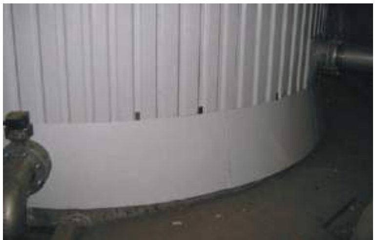
Рис. 8. Низ профилированного листа, установленный в кляммеры
