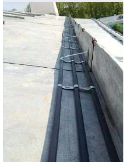
и Рис.1. Пример размещения нагревательных кабелей в настенном водоотводном желобе.
